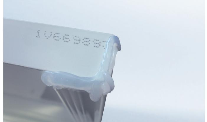
**2** Dichtstoff rückseitig zwischen Anschraubsteg und Bordstück auftragen
